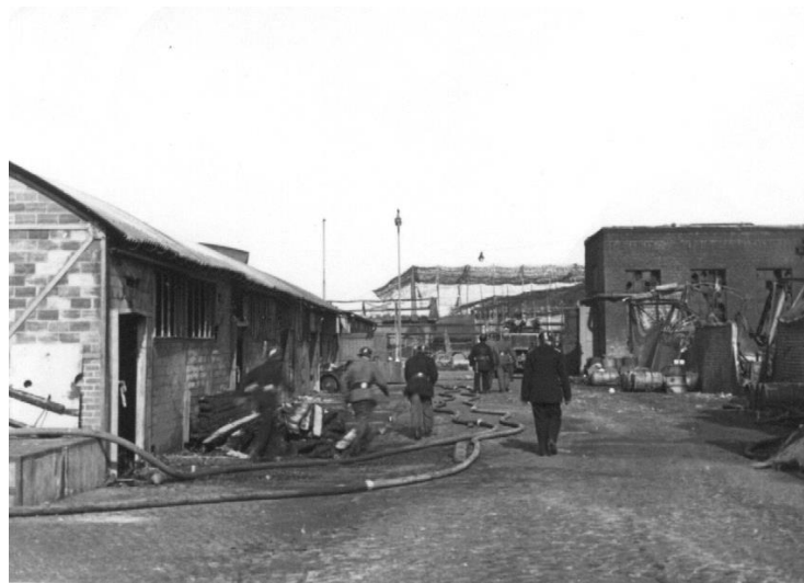
Die Wedeler Feuerwehr bei Nachlöscharbeiten
