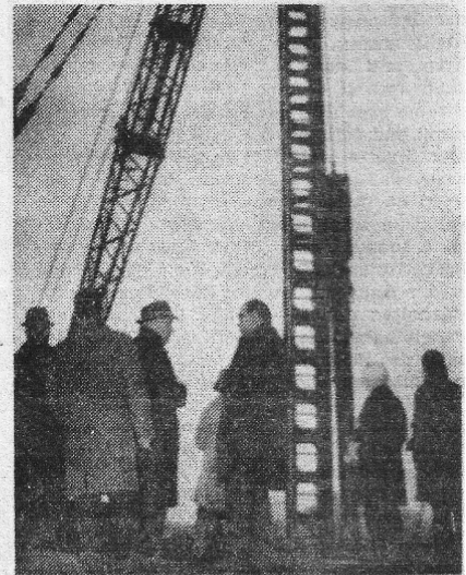
Der erste Pfahl wird in den Boden gerammt.
