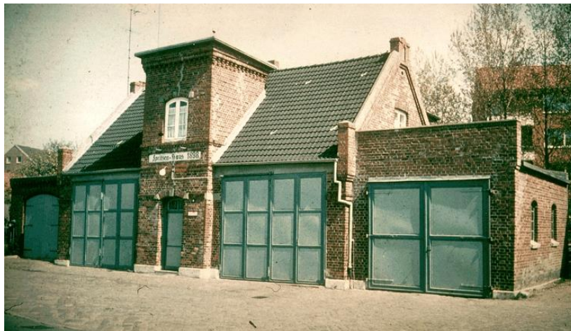
Feuerwache Bekstraße hinten ist nur schwach der kleine Funkmast zu erkennen
