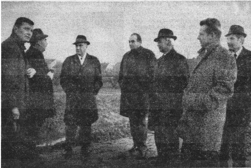
Gestern auf dem Gelände der neuen Feuerwache (von links): zwei Vertreter der Hanseatischen Tiefgründungsgesellschaft, Bürgermeister Dr. Winkler, Stadtrat Fahrenkrug, Bauamtsleiter Liebmann, Wehrführer Jüttemeier und sein Stellvertreter Karolewitz.
