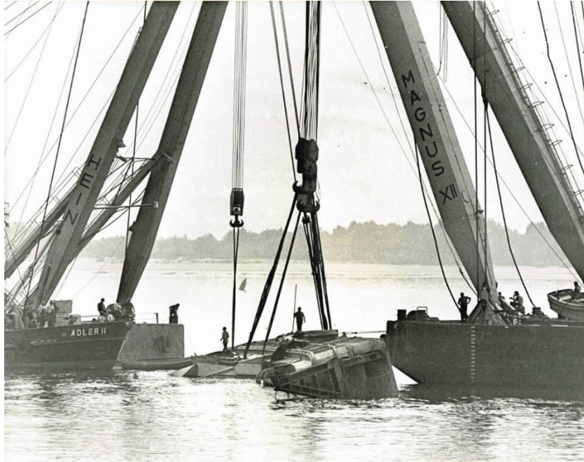
Bergen des untergegangenen Baggers
