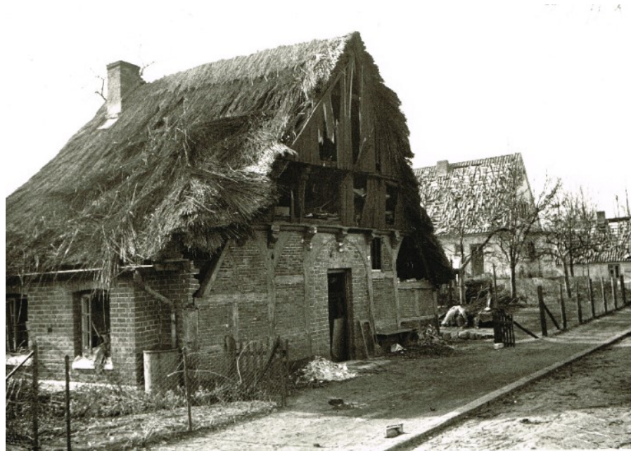
Das alte Gebäude wurde nach der Zerstörung abgebrochen. Foto: J. Schorer, 1943
