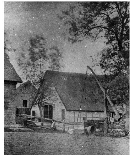
Der Hof Nr. 20 vor dem Umbau 1908 (Foto 5 – 0575, Stadtarchiv)
