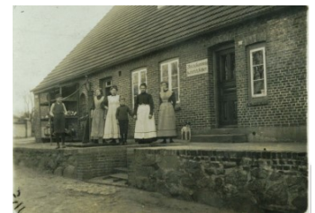
Der Hof Nr. 20 nach dem Umbau 1908
