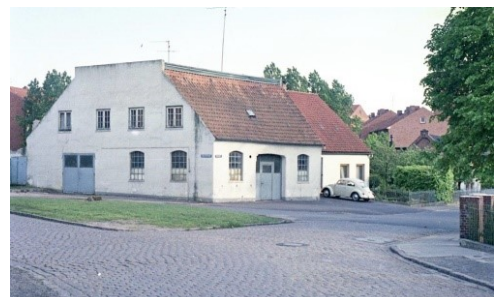
Die Schmiede wurde 1972 abgebrochen. Der große Ahornbaum ist schon weg. (Foto: S 13-17, G. Maushake, Stadtarchiv)
