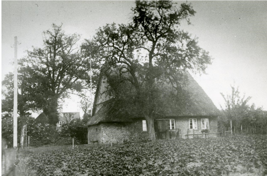
Das Haus von Hof Nr. 36 in der Bekstraße 25, vermutlich Anfang der 1770er Jahre gebaut. Links im Hintergrund erahnt man das Haus von Hof Nr. 20, die Meierei von Heinrich Köhler, Ecke Bekstraße / ABC-Straße. (Foto: 1 – 1413, Stadtarchiv)
