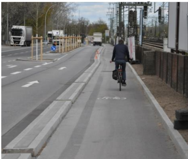
Abbildung 100: Beispiel für geschützten Radfahrstreifen (Hannoversche Straße, Hamburg)
