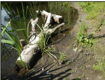
Totholzeinbau Wandse, BWS GmbH 2016
