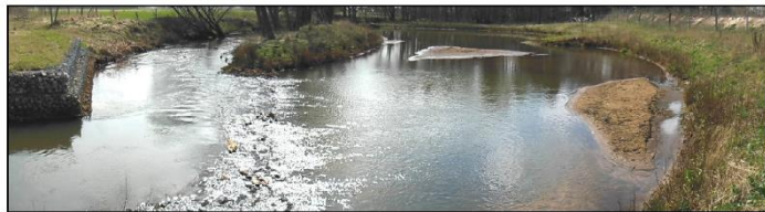
Sandfang im Nebenschluss Schattlunder Mühlenstrom, BWS GmbH 2013
