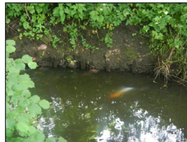
Sicherung durch Steinwalzen Wedeler Au, BWS GmbH 2016
